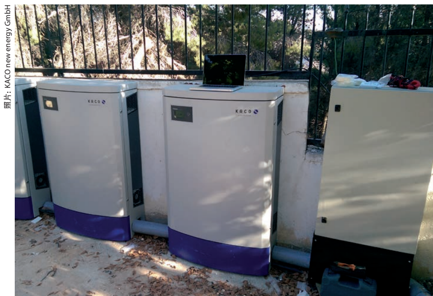
王子穆罕默德·本·塔拉勒皇家宫殿的太阳能光伏发电系统由KACO new energy公司的Powador 60.0 TL3逆变器供电。
