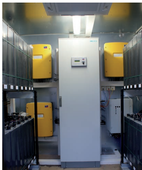
外壳几乎完全密封，为电池和电源电子设备提供可控气候环境。
