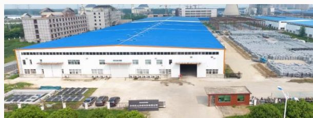
5億元投資，20000m 2 浮體生產基地
