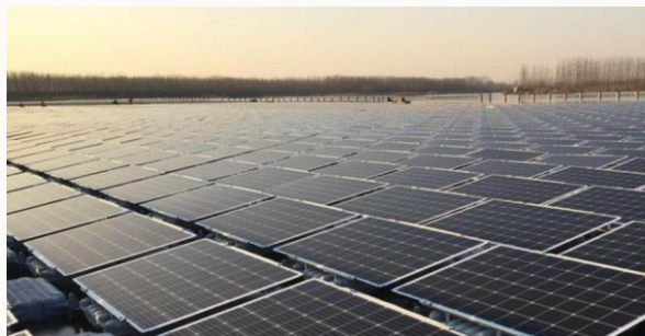
淮南新集 裝機容量：102MW
