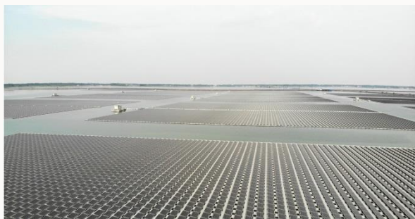
淮南顧橋 裝機容量：150MW
