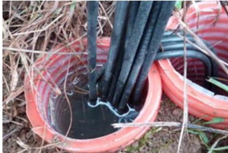
Détérioration de l'isolant si contact prolongé avec l'eau
