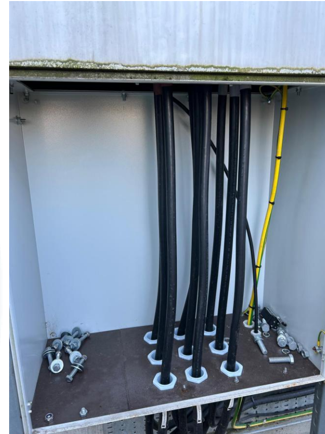
Cables con tensión sin cristal protector
