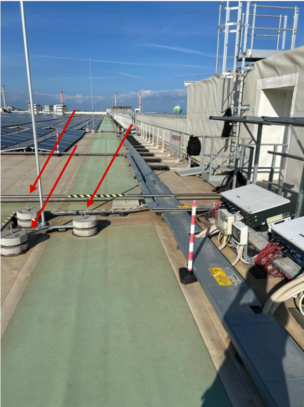
Espigas de lastre sin protección
