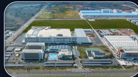
Sito Produttivo a Guangde (Phase III), China
